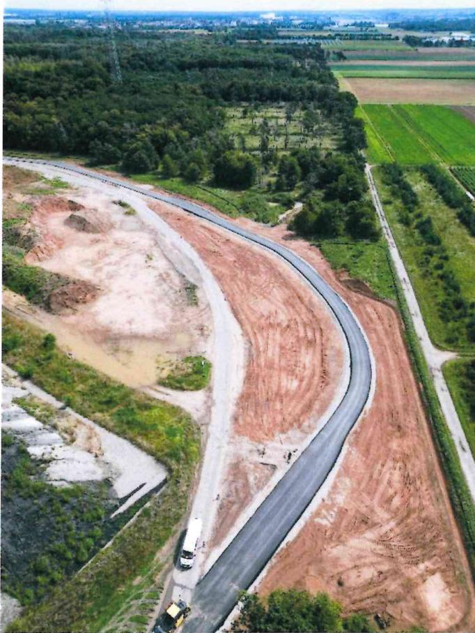
Das zusätzliche Ablagerungsvolumen kommt durch die geometrische Anpassung von zusätzlichen 0,46 ha der Felder 9+10 und durch die größere Endverfüllhöhe der Felder 6 bis 10 zustande.
