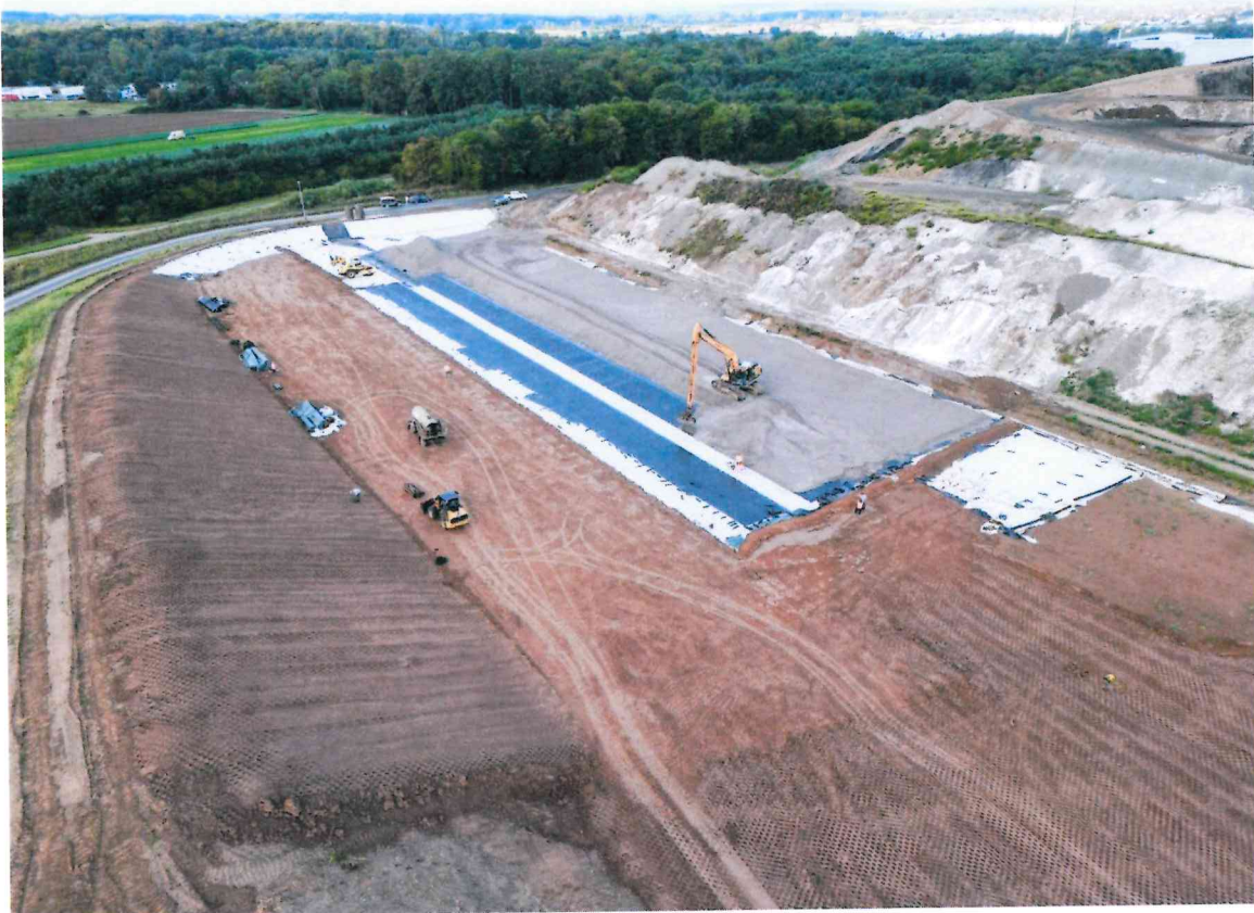
Abbildung 2: Luftbild Basisabdichtung Feld 10 im September 2025
